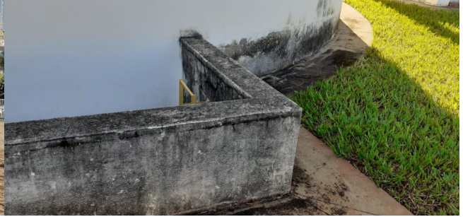
Autor: AMAE/Rio Verde Descrição: Ponto de acesso ao extravazor
