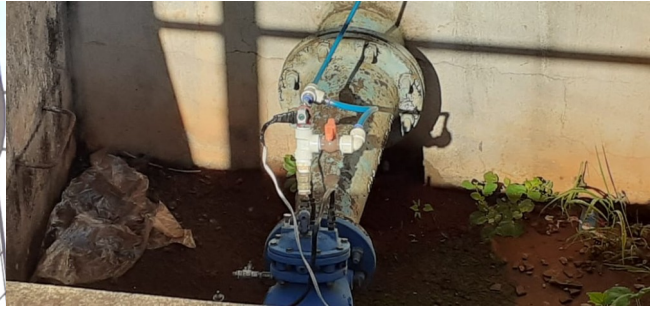
Autor: AMAE/Rio Verde Descrição: Sensor telemétrico de nível RAP
